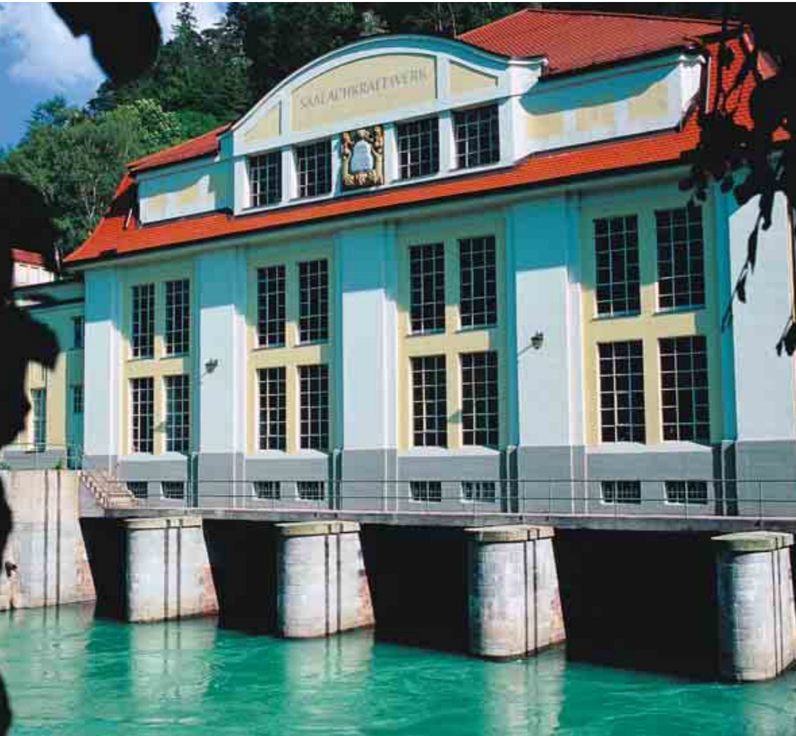
Wasserkraftwerk, Bad Reichenhall
